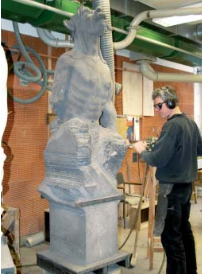
6. Steinmetz Sebastian Becker bei der Arbeit an dem Wasserspeier für Strebepeer F 5.
