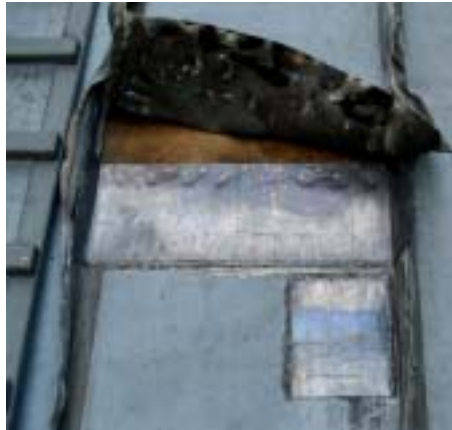
13. Reparatur der Bleibleche an den Seitenschiffdächern der Westseite des Südquerhauses.
