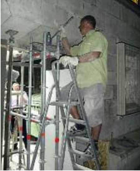
13. Michael Schlig bei der Befestigung des Schlusssteines im Sturz der Arbeitstür.
