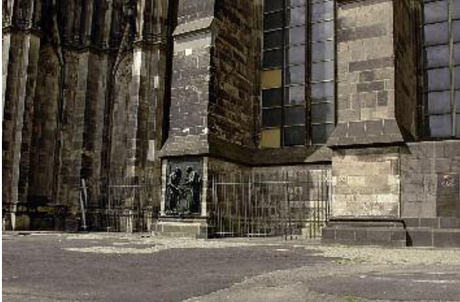
20. Neue Gitter an der Langhaussüdseite.
