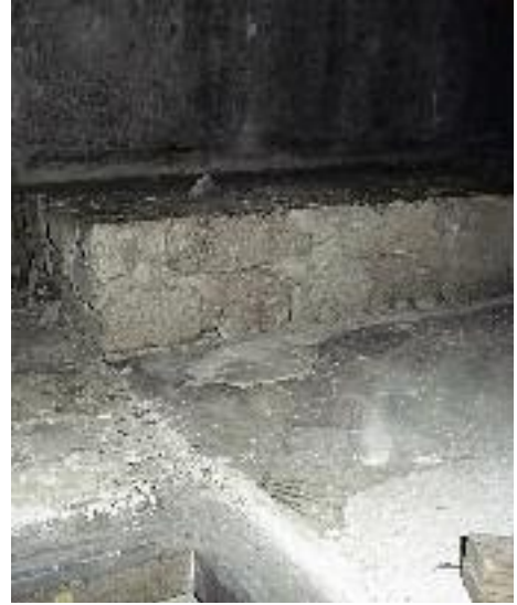
14. Bimssteinsockel unter dem Agilolphusaltar während des Abbruchs.
