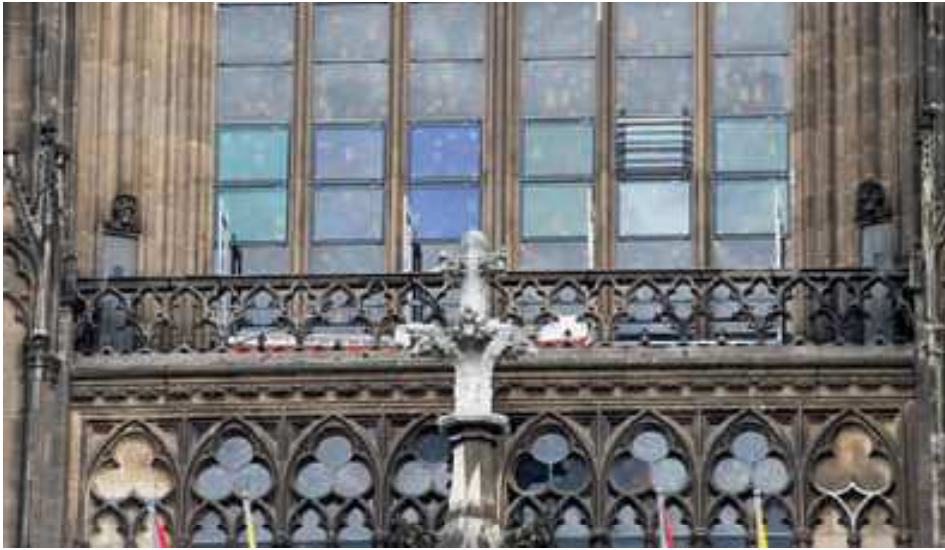
23. Probehängung von Antireflexgläsern verschiedener Hersteller (Schott, Trösch und Pilkington) vor dem Südquerhausfenster.
