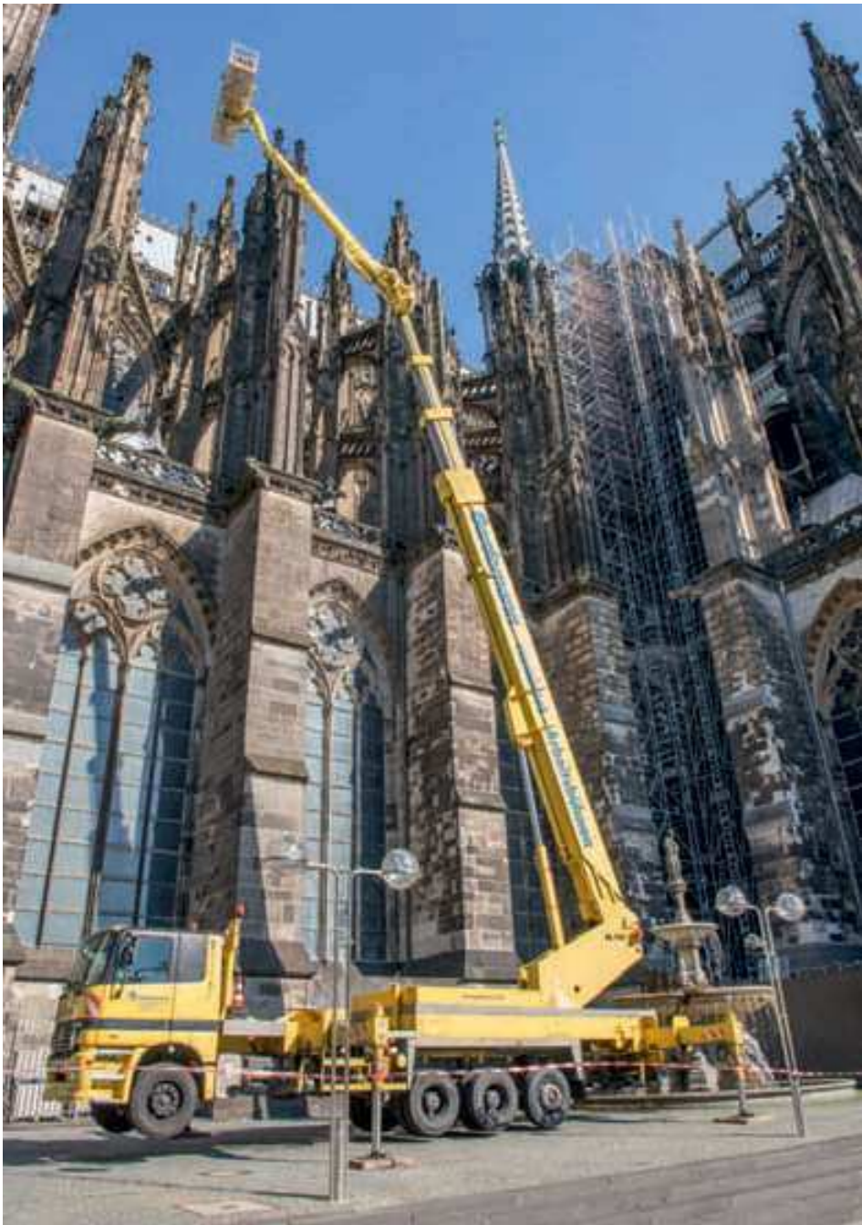
14. Sicherheitsbefahrung der Südseite des Domes mit einem Hubsteiger.
