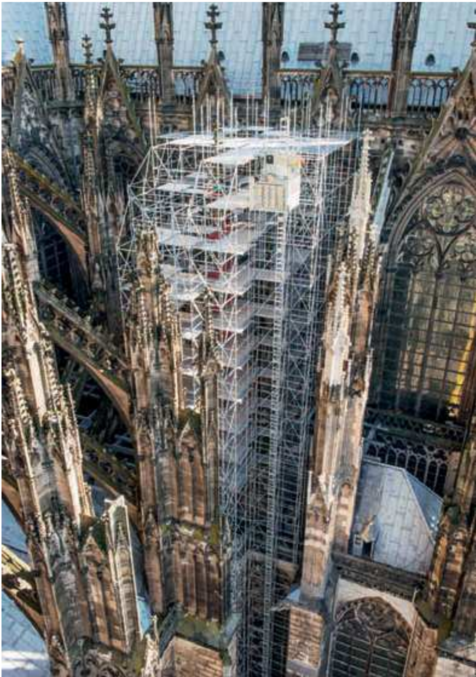
4. Das vollendete Gerüst an Strebepfeiler A 8–A 9.
