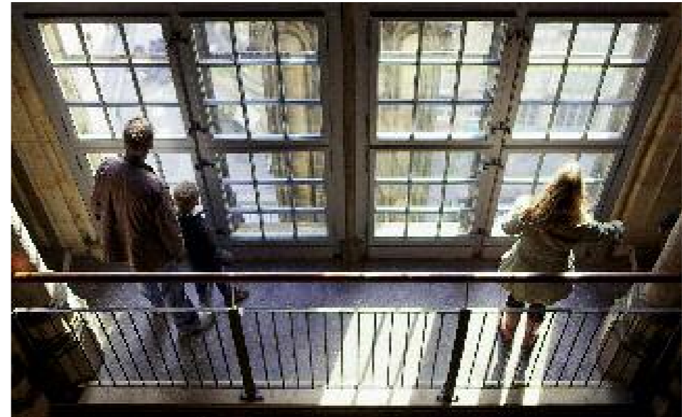
12. Erneuerte Fenster im Glockenstuhl des Südturmes.
