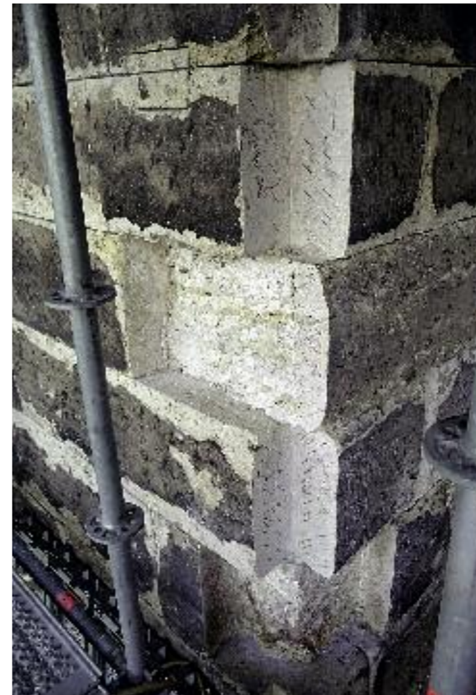
2. Ecke des mittelalterlichen Strebepfeilers F 5 nach Entfernen späterer Ergänzungen.
