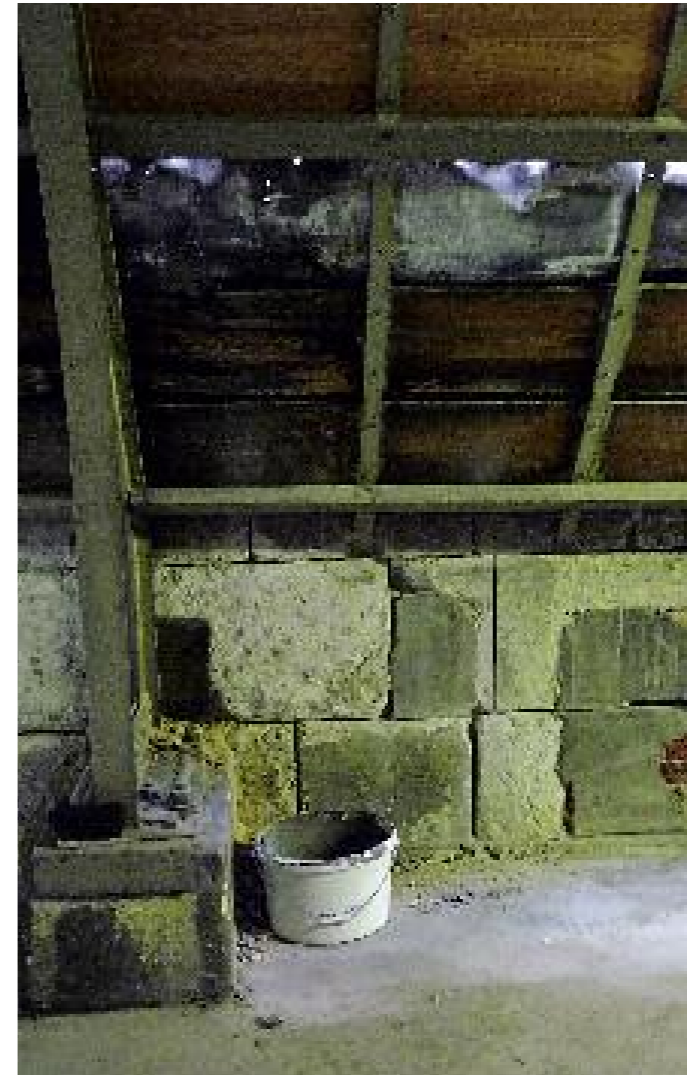
11. Verfaulte Dachbohlen, beschädigte Bleiabdeckung und mit Ziegeln ausgebesserte Außenmauer im östlichen Seitenschiffdachstuhl des Nordquerhauses.
