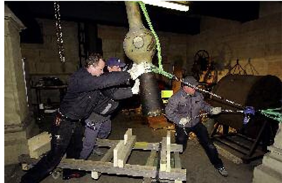
15. Ablassen des Klöppels aus dem Glockenstuhl.
