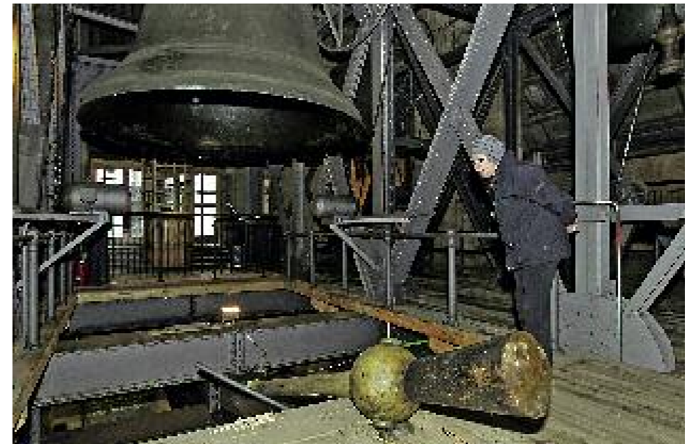
13. Klöppel der Petersglocke unmittelbar nach dem Absturz.
