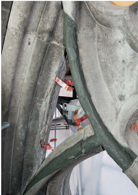
11. Steinganzung am Mawerk des Mirjamfensters.
