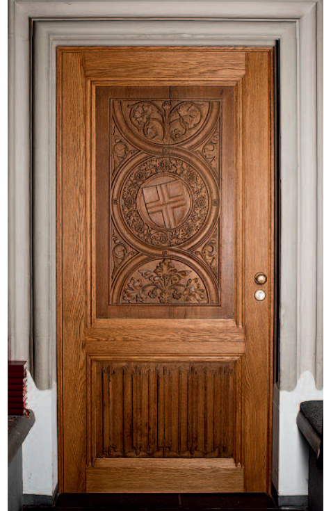
15. Aufgedoppelte Verbindungstür zwischen Sakristei und Sakramentskapelle, Endzustand.
