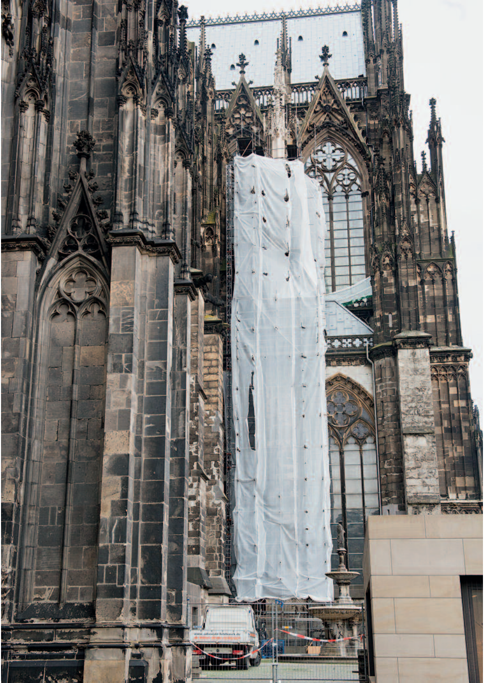
2. Strebesystem H 8–H 9 unmittelbar vor Abbau des Gerüstes.
