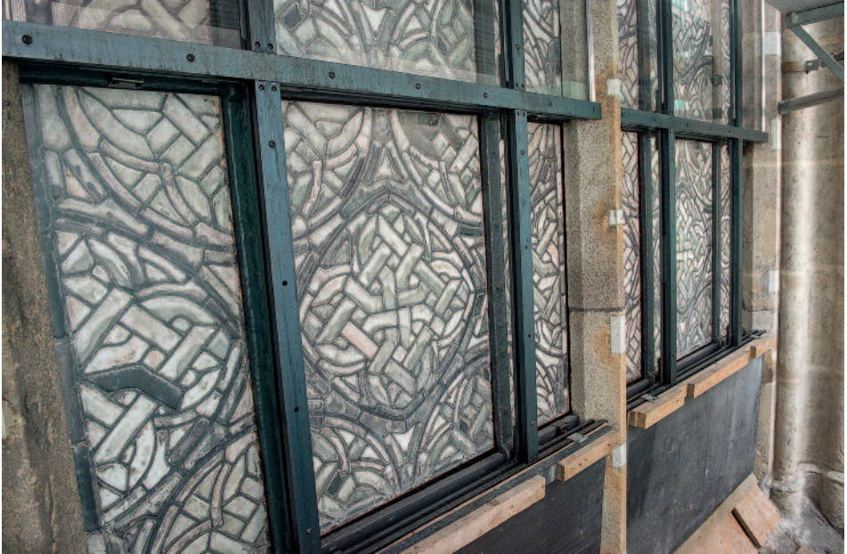
19. Ersatzverglasung im Königsfenster N V mit beidseitig laminierten Fotoimitaten, Außenseite.
