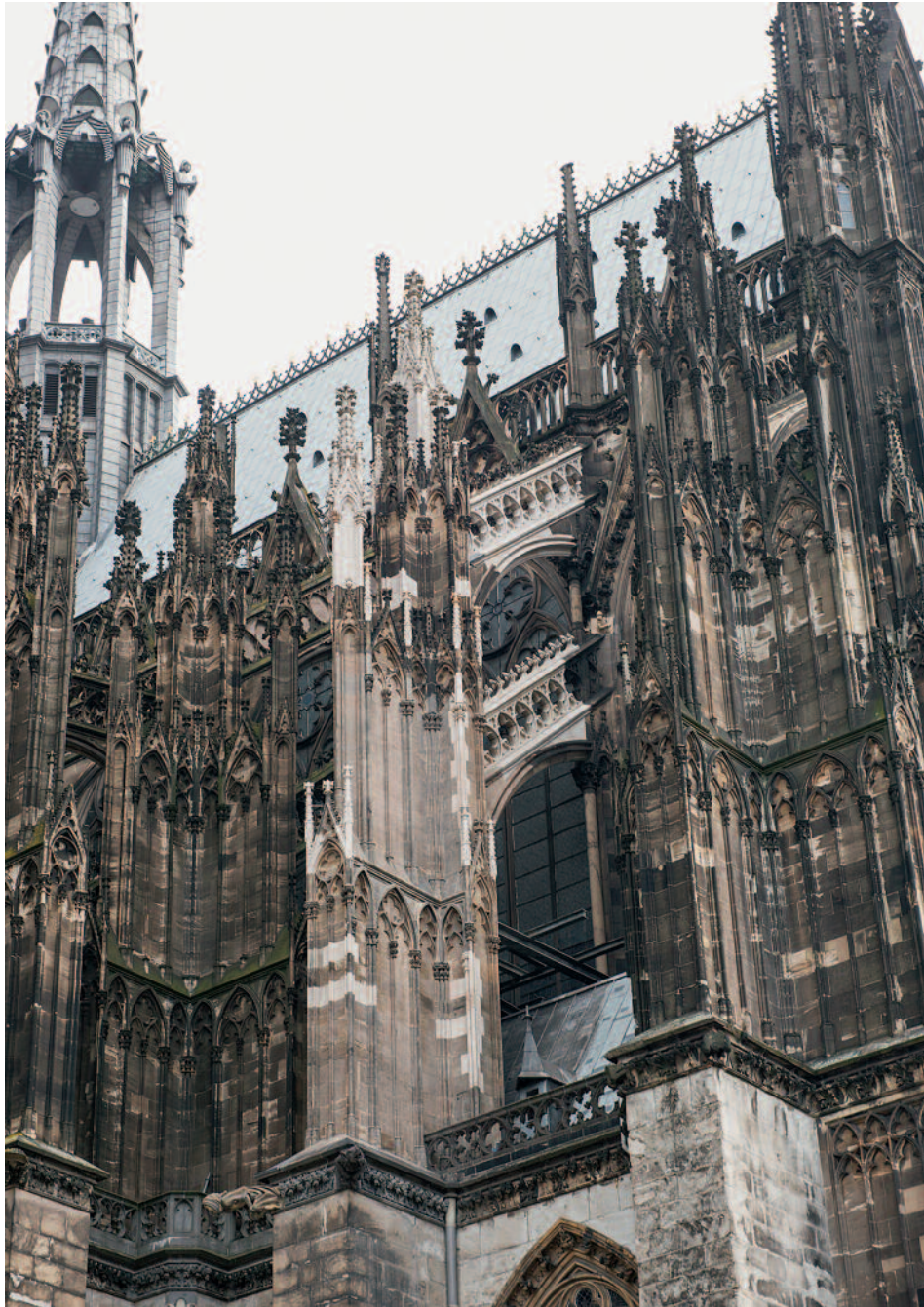
3. Strebe Pfeiler F 5 nach Abbau des Gerüsts.
