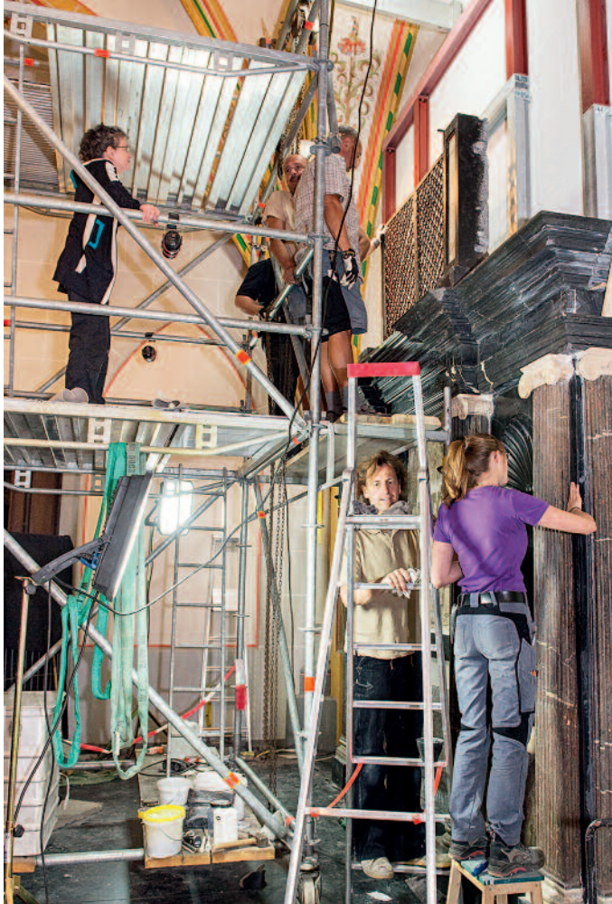
10. Wiederaufbau der restaurierten Rückwand des barocken Dreikönigenmausoleums in der sog. Hubertuskapelle.
