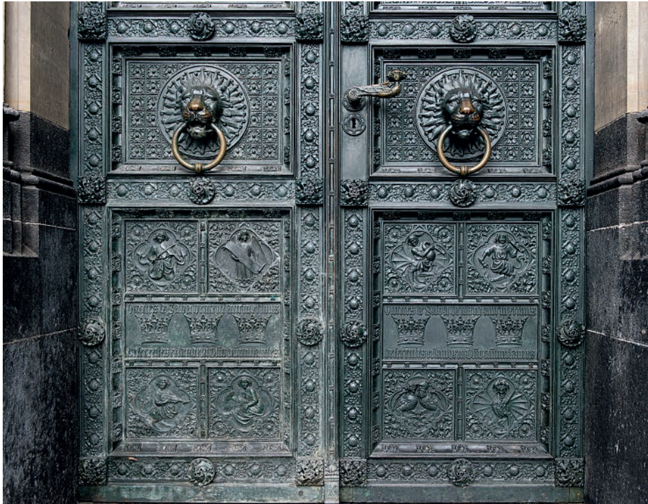
17. Tür des Dreikönigenportals vor der Reinigung (links) und nach der Reinigung und Behandlung mit Wachs (rechts).
