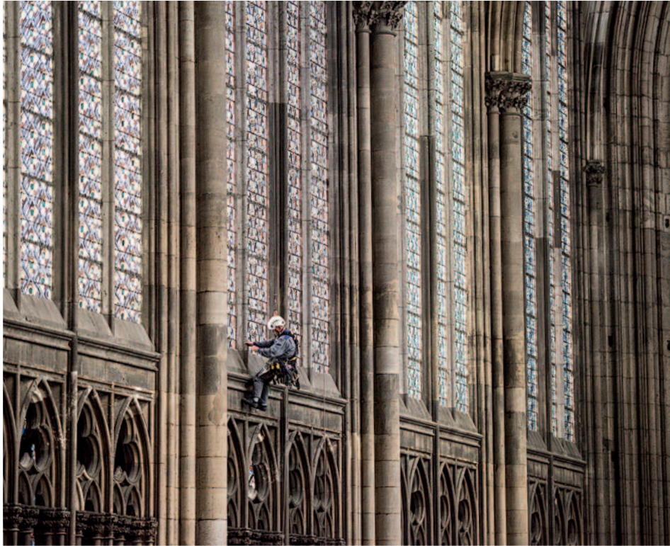
4. Gerüstbauer Wolfgang Schmitz bei der Kontrollbefahrung der Langhausfenster.
