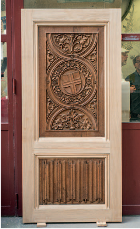
14. Aufgedoppelte Verbindungstür zwischen Sakristei und Sakramentskapelle, Zwischenzustand.
