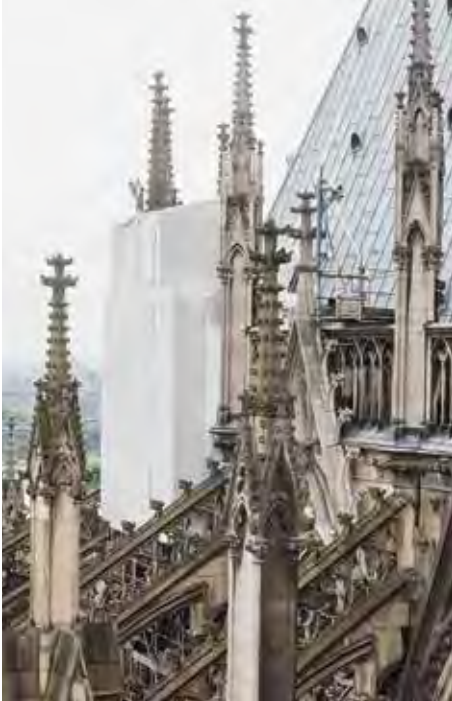
4. Schutzeinhausung des Wimpergs über Fenster N IV (D 14–D 15).
