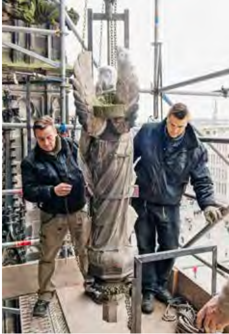
17. Abnahme eines stark verwitterten Engels vom Wimperg über dem Petersportal.
