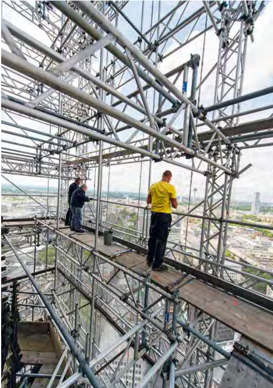
2. Gerüstbauer bei der Montage der Schutznetze am Hängegerüst des nordwestlichen Nordturmpfeilers.
