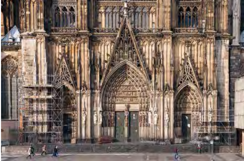
3. Abbau des Gerüsts am westlichen Pfeiler der Südquerhausfassade G 8 und Aufbau des neuen Gerüsts an G 11.
