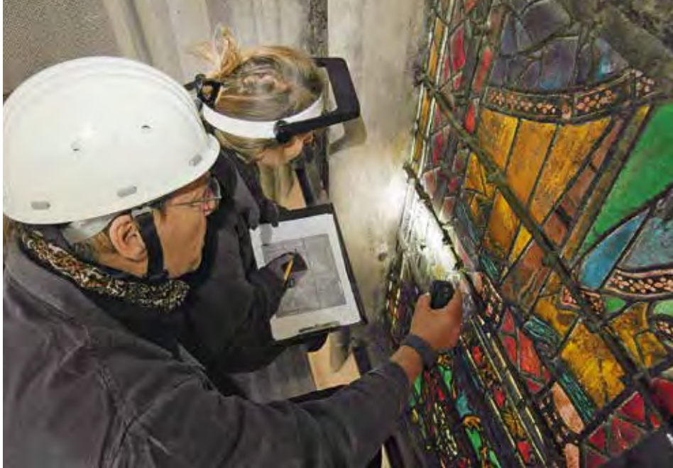
21. Zustandsdokumentation von Fenster N IV vor dem Ausbau.
