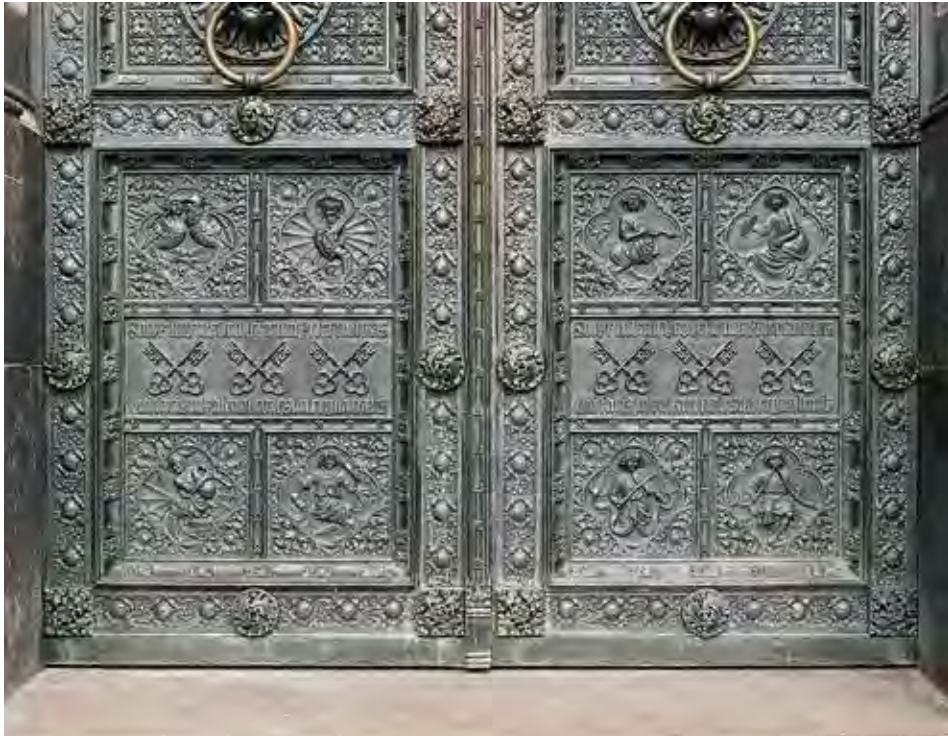
20. Türflügel des Petersportales nach Reinigung und Wachsung.
