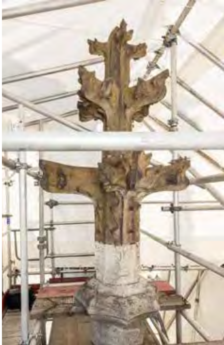
6. Kreuzblume auf dem Wimperg über Fenster N IV (D 14–D 15) vor der Reinigung.
