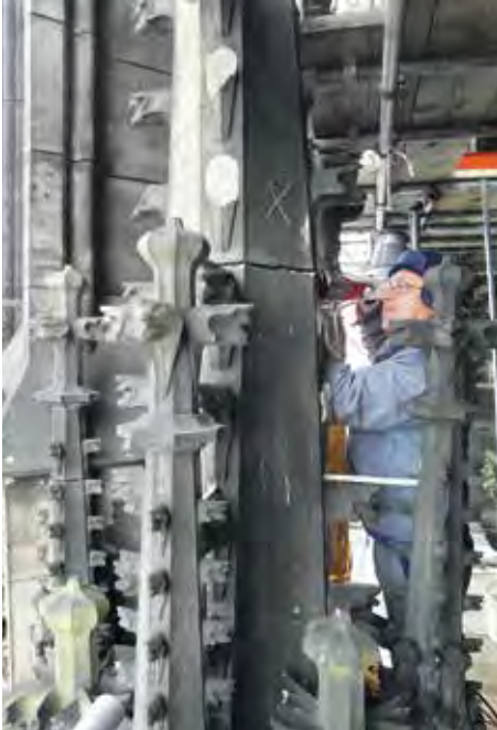
15. Abbau eines gefährdeten Fialaufbaus an Nordturm Pfeiler F 1.
