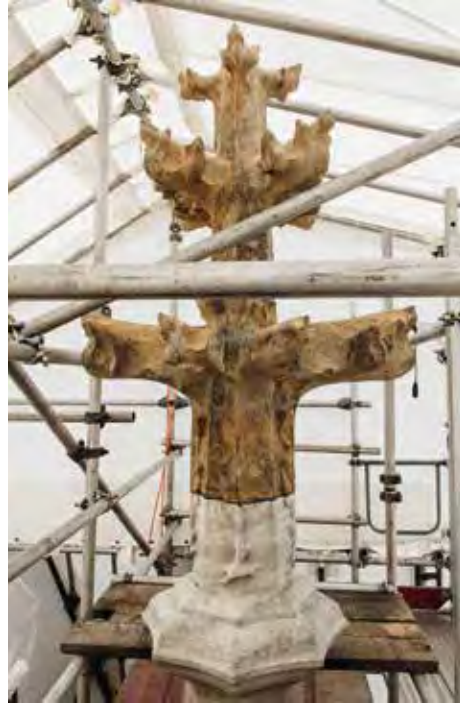
7. Kreuzblume auf dem Wimperg über Fenster N IV (D 14–D 15) nach der Reinigung.
