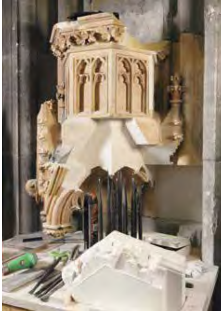
8. Kriegsbeschädigter Konsolbaldachin im Michaelportal nach Reinigung und Vorbereitung zum Einbau von Vierungen.
