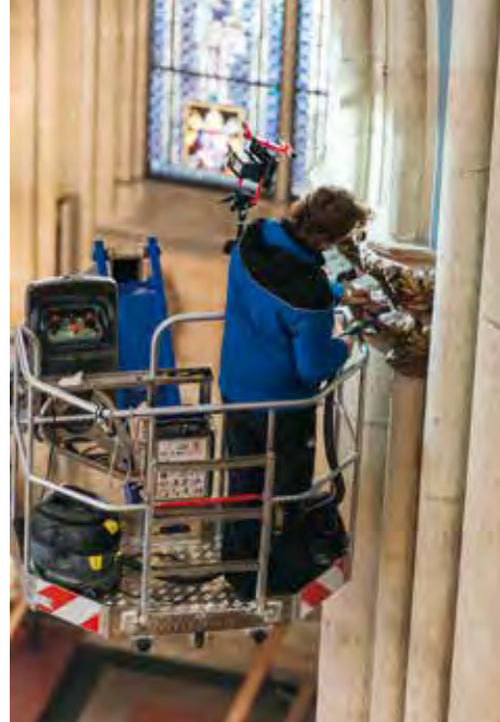
33. Reinigung der Chorpfeilerkapitelle.
