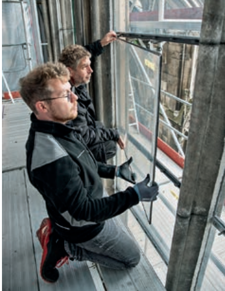
16. Einbau von Verbundsicherheitsglas in das Helenafenster durch die Mitarbeiter der Glasrestaurationswerkstatt Felix Busse und Ralph Wolter
