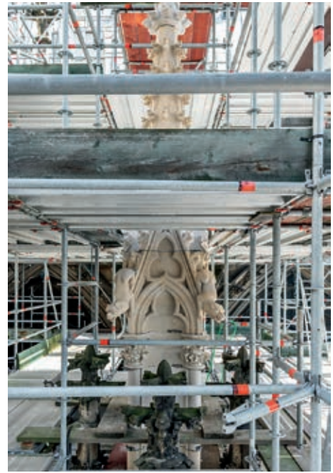
3. Neu versetzte Fiale über Pfeiler A 8 im Strebenwerk des südlichen Langhauses
