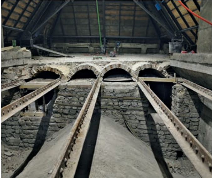
14. Kontrollierter Rückbau der preußischen Kappendecke über Feld 45 und 46
