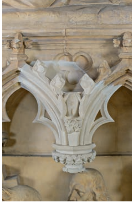
9. Ergänzung am oberen Baldachin des Tympanons
