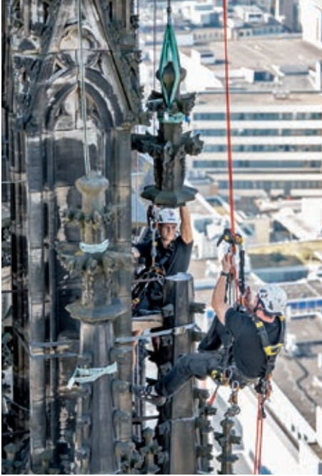
2. Bergung einer Kreuzblume am Südturm aus 95 Metern Höhe durch die Gerüstbauer
