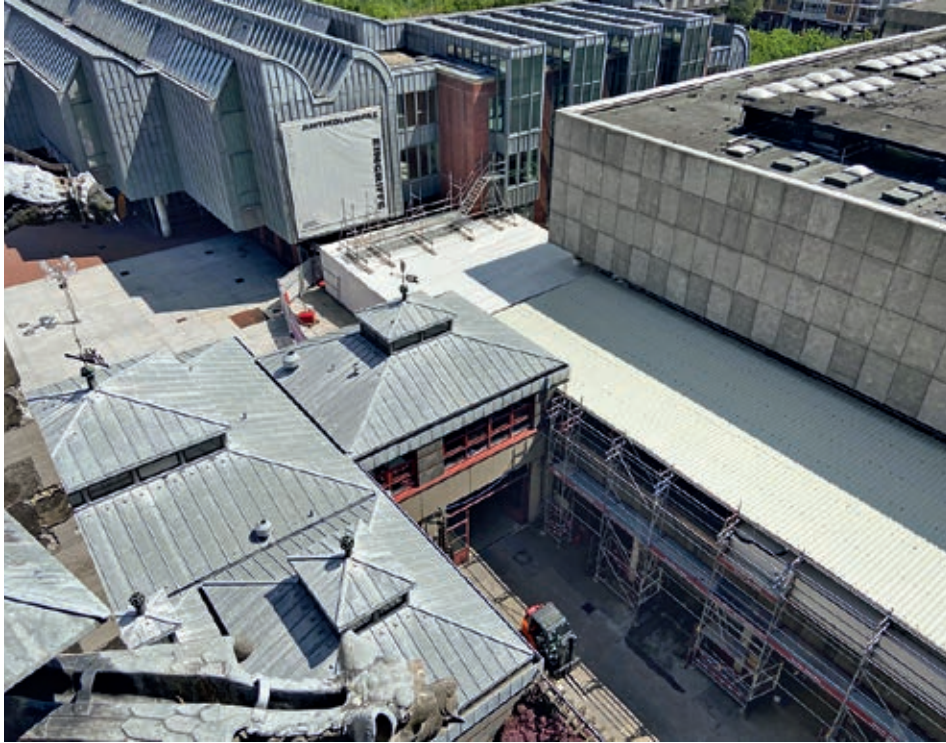
25. Sanierung der Werkstattdecken der Kölner Dombauhütte, Blick auf das Wetterschutzdach
